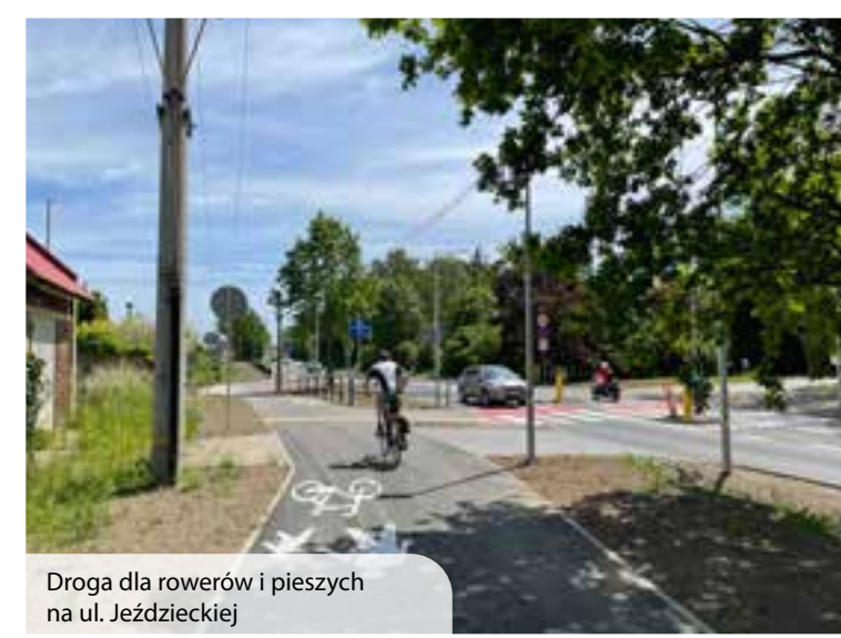
Droga dla rowerów i pieszych na ul. Jeddziekiej
